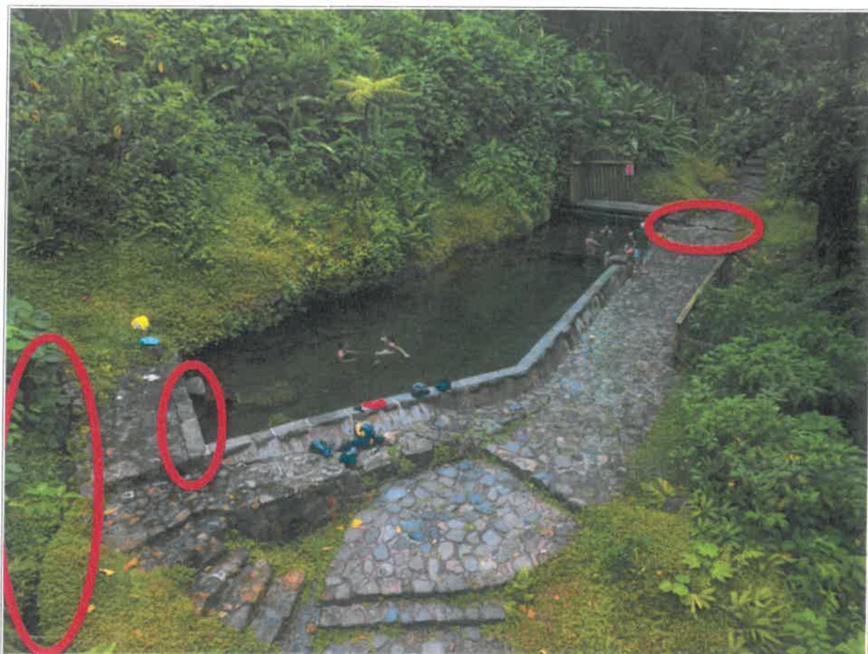
Vue aérienne du bassin des Bains Jaunes et zones des travaux
